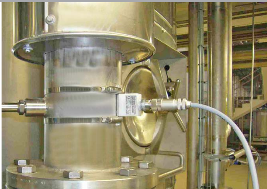
LABOMs Widerstandsthermometer Clamp-on-Technik - die Alternative zur konventionellen invasiven Temperaturmessung an einer Rohrleitung
